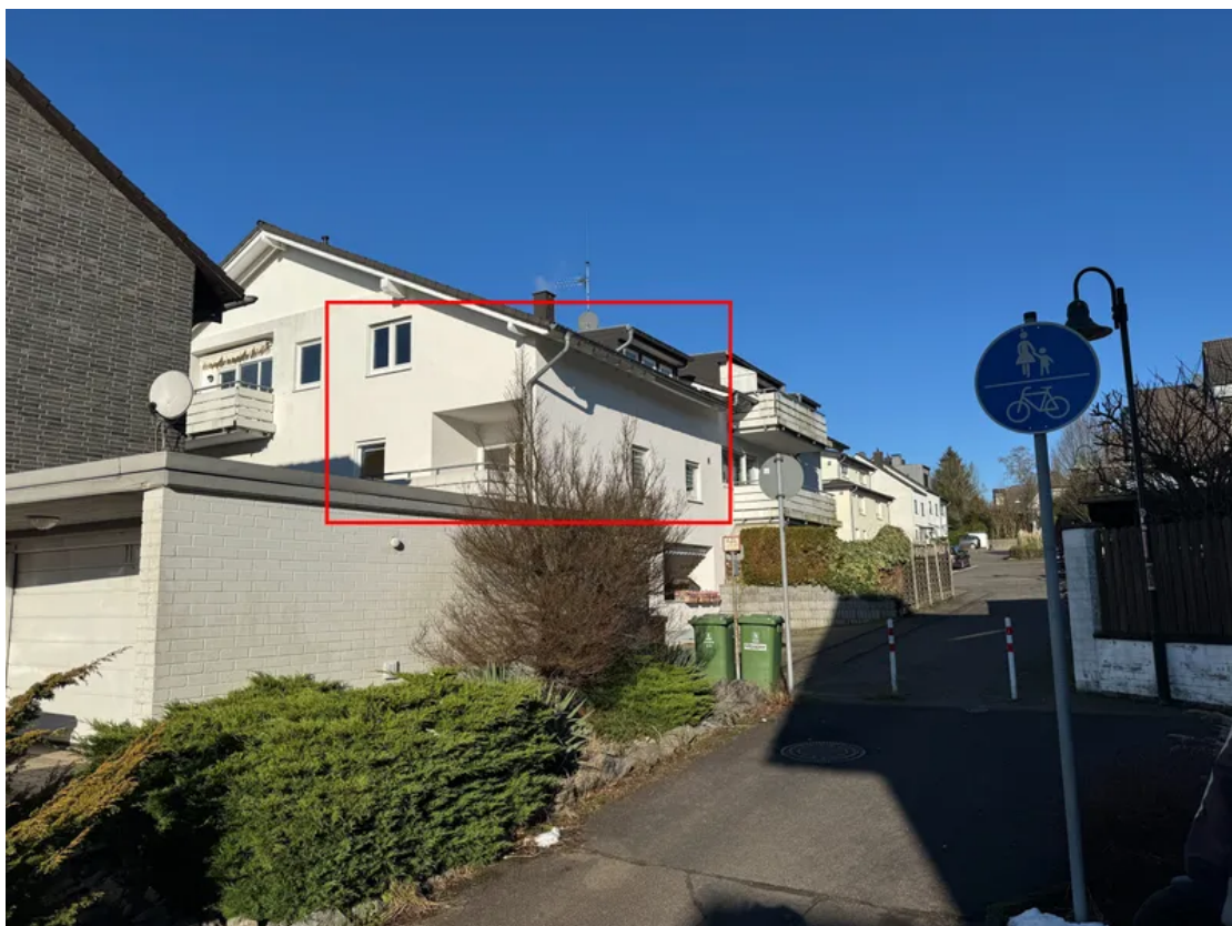
Ansicht aus Süden
